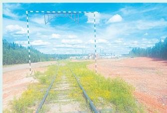
На территории будущего терминала приемки и отгрузки круглых лесоматериалов начинаются работы на железнодорожном тупике. Запланировано переустройство железнодорожных стрелок. Также будут заменены на новые шпалы, пришедшие в негодность, выровнены рельсы, подсыпано щебнем полотно железной дороги. Модернизация железнодорожного тупика проводится параллельно строительству новых объектов терминала.
