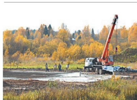
Завершено устройство фундамента под будущую котельную в с. Березник. К монтажу котельного оборудования и каркаса здания строители приступят весной 2018 года, а запуск автоматизированной котельной мощностью 6 МВт, работающей на пеллетах, намечен на сентябрь 2018 года. Прокладка новых инженерных сетей, которые свяжут котельную с производственной базой УЛК, охотхозяйством «Медведь» и всеми объектами социальной сферы села, также завершится в 2018 году.
