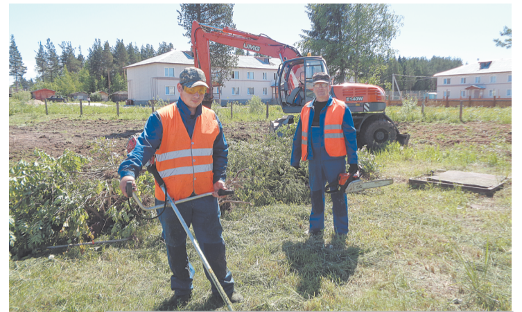
Благоустройство ЗСО (зоны санитарной охраны) водозаборной скважины ведут Николай Никулин, Вячеслав Проняев и экскаваторщик Алексей Шубин
