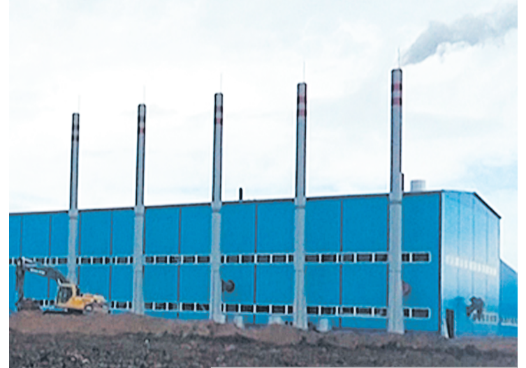
Первый пробный дым новой котельной
