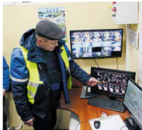
Начальник котельной №1 Сергей Худашов
