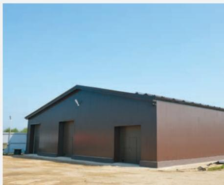
Завершена реконструкция здания склада импортных запчастей. Площадь склада увеличена практически в два раза, сделана новая теплая кровля. Внутри здание обшито профлистом, полы забетонированы, смонтировано светодиодное электроосвещение, установлена пожарная сигнализация и видеонаблюдение. На въезде в склад установлены современные автоматические ворота.
